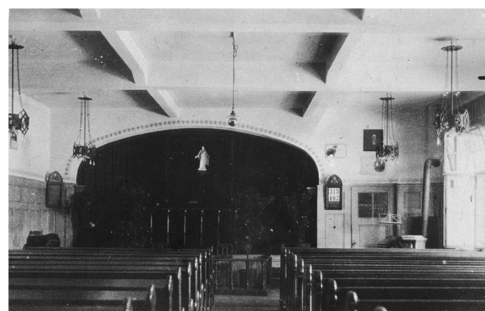
Der ehemalige Tanzsaal mit der Bühne ist noch gut zu erkennen. Vorne rechts steht der alte Holzofen.
