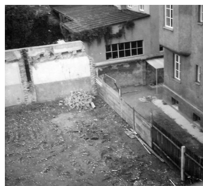
Nun kann der Grundstein gelegt werden (Blick nach Nordosten).
