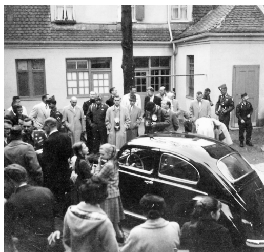
Der Pastor bekommt ein Dienstfahrzeug. Im Hintergrund: links Toilettenfenster, Mitte Sonntagsschulraum, rechts Waschküche für die Mieter (früher Schlachthaus).
