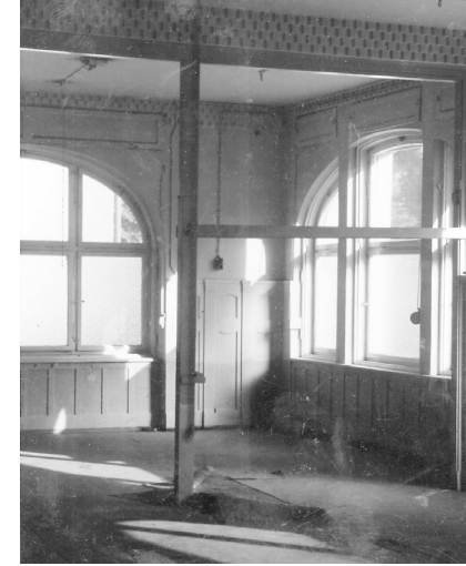
Die Näherei ist ausgezogen. Jetzt kann der Saal renoviert werden.
