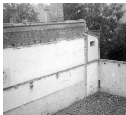
Der Bauplatz ist freigeräumt (Blick in Richtung Innenstadt).
