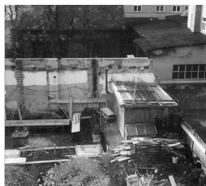
Die Rückgebäude werden abgebrochen (Blick nach Nordwesten).
