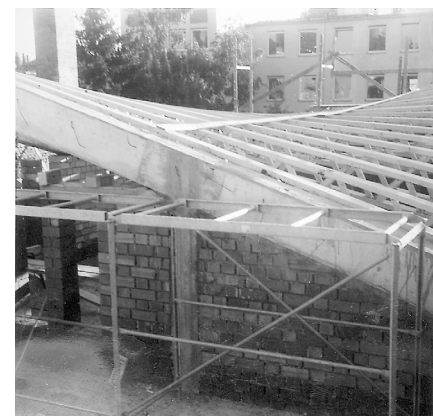
Die Dachkonstruktion des Kirchenneubaus
